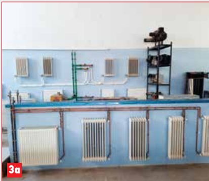
ΦΩΤΟ 3: Το Εργαστήριο Θερμοδυναμικής περιλαμβάνει θερμαντικά σώματα (3α) που κατασκευάζουν οι φοιτητές, λέβητα (3β) και κυκλοφορητή ζεστού νερού χρήσης (3γ). ΦΩΤΟ 4: Τριδιάστατος εκτυπωτής στις εγκαταστάσεις του παλαιού μηχανουργείου.
