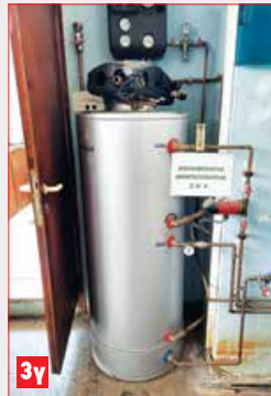
ΦΩΤΟ 3: Το Εργαστήριο Θερμοδυναμικής περιλαμβάνει θερμαντικά σώματα (3α) που κατασκευάζουν οι φοιτητές, λέβητα (3β) και κυκλοφορητή ζεστού νερού χρήσης (3γ). ΦΩΤΟ 4: Τριδιάστατος εκτυπωτής στις εγκαταστάσεις του παλαιού μηχανουργείου.
