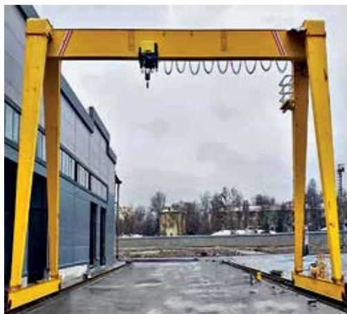
ΕΙΚΟΝΑ 5: Γερανογέφυρα τύπου πυλώνα με δύο σκέλη
